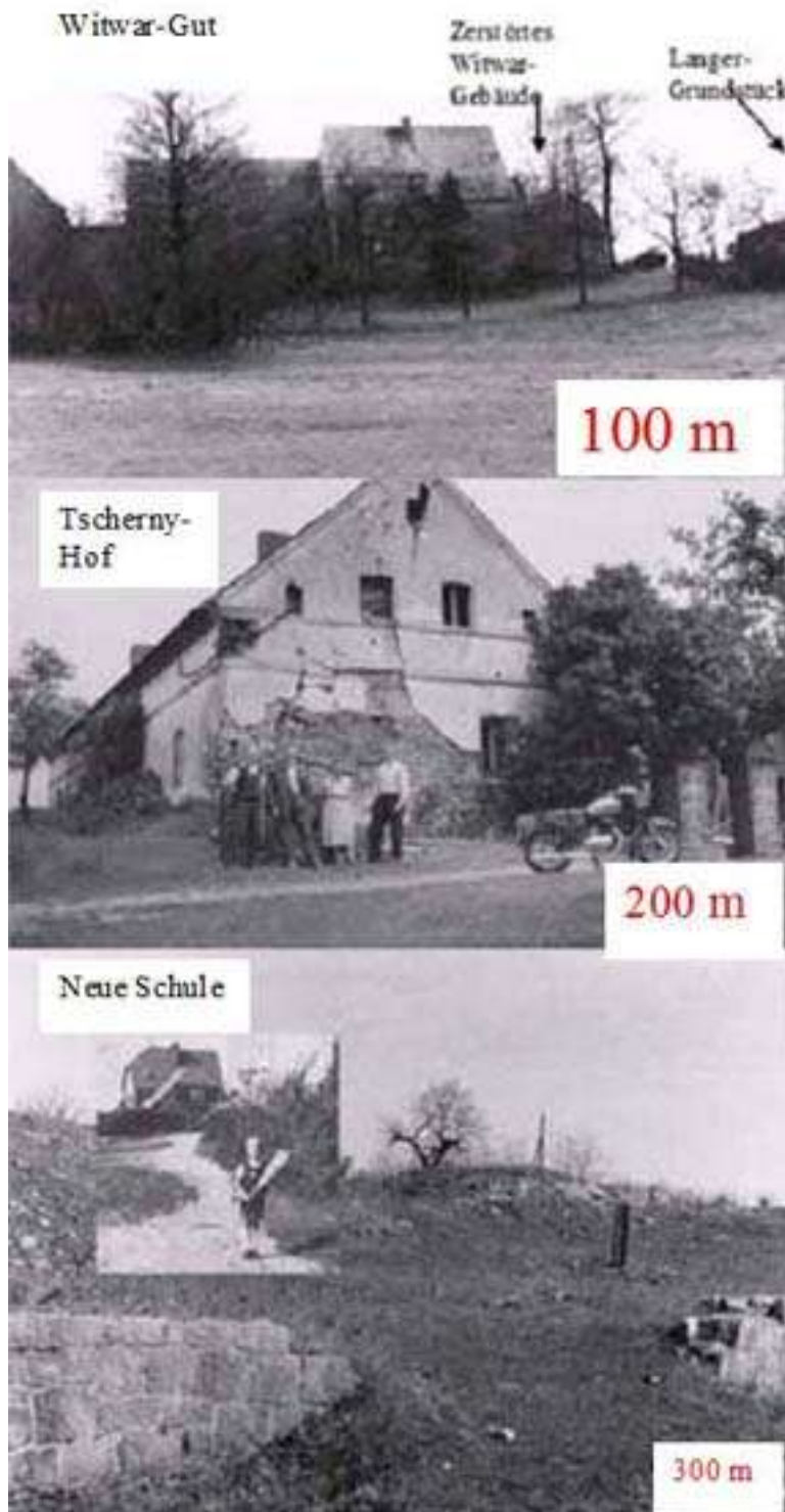
Bild 1: Kriegsschäden in der Nordhälfte von Friedrichstein/Hussinetz in der unmittelbaren Umgebung meines Elternhauses: Im Witwarschen Gut wurde ein Gebäude getroffen (ausgebrannt), vor dem Wohnhaus-Giebel von Tscherny's ging eine Granate nieder (Mauerwerksrisse), die Neue Schule wurde vollkommen zerstört (Fotos: Familien-Album Tscherny).
